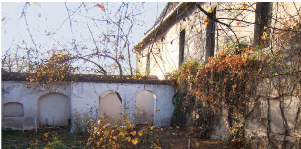
7 Imagine generală cu partea de sud a bisericii și ruinele clădirilor dispărute
