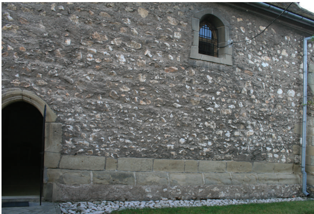
5 Fațada de nord, detaliu de zidărie cu soclul din blocuri de piatră
