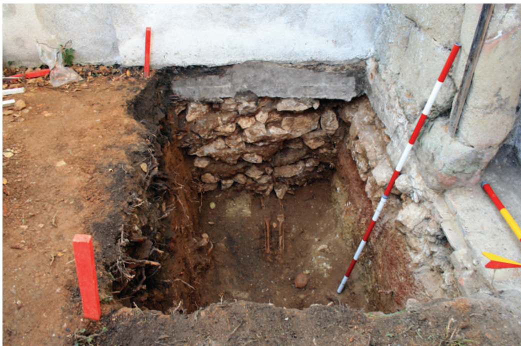
9 Fundația zidului de pe latura sudică a bisericii
